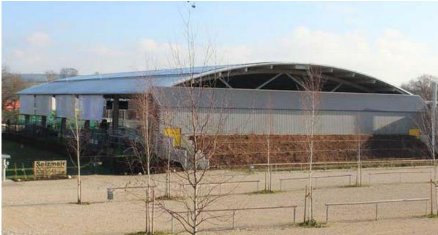
Bild 1 Eishalle der Stadt Pfaffenhofen
